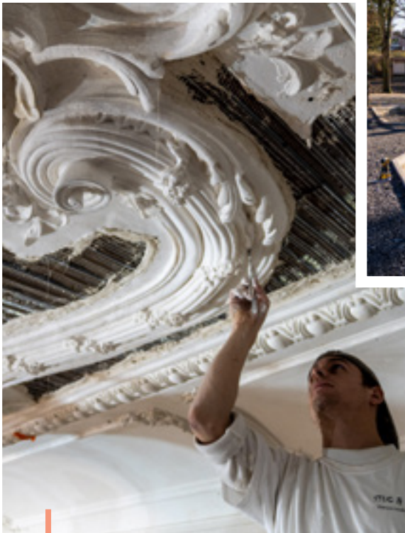
Les travaux de restauration du salon blanc s'achèveront cette année
